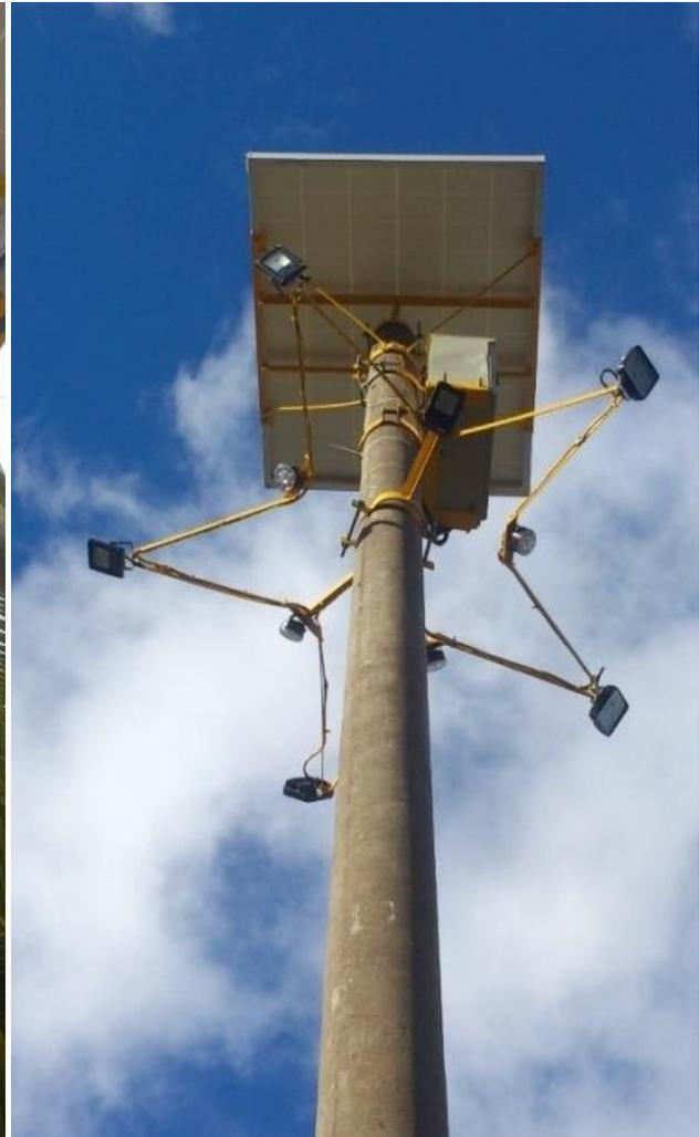
Alumbrado con energía solar en el parque de Chita - Boyacá, año 2016. Se sustituyeron antiguas luminarias que consumían 115 kWh diarios, logrando reducción de emisiones contaminantes en -2,6 Ton al año, subproductos de la generación de electricidad por métodos convencionales.
