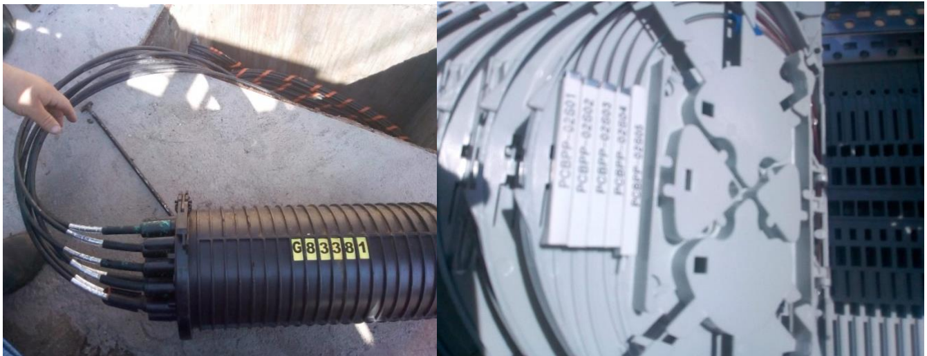
“Fist Secundaria Construída com toda qualidade técnica (unifilar 5 splitter) esperada na rede GPON da COPEL TELECOM” Contrato: COPEL TELECOM
