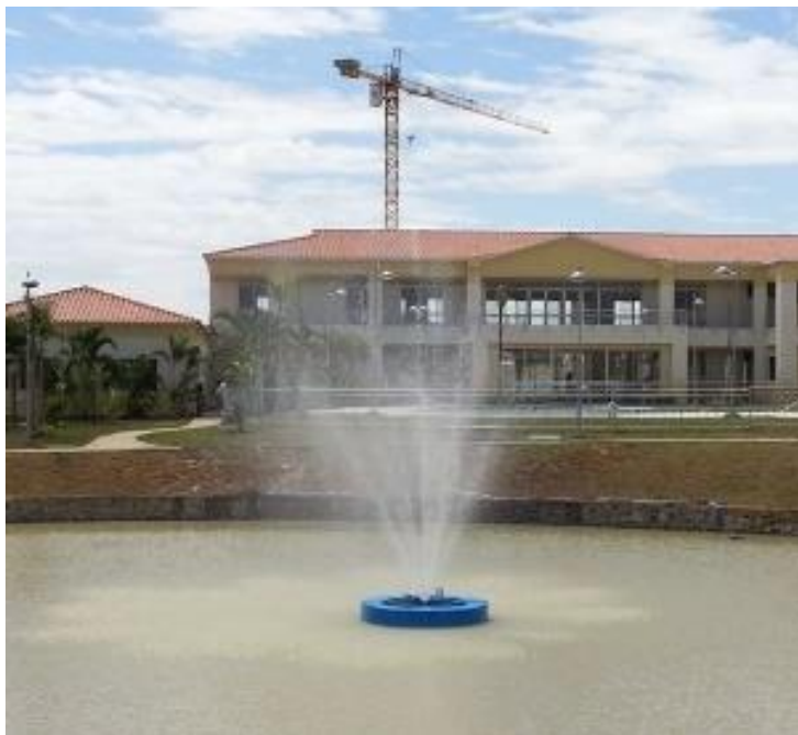
Diseño, construcción e instalación de fuente flotante “condominio Reserva de la Sierra”, Neiva (Huila)
