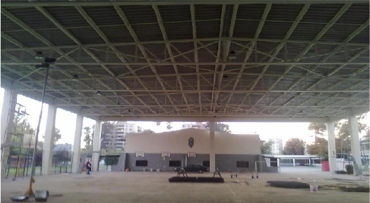
Esta obra incluye fundaciones para pilares prefabricados, montaje estructura de hormigón, fabricación y montaje de estructura metálica y cubierta
