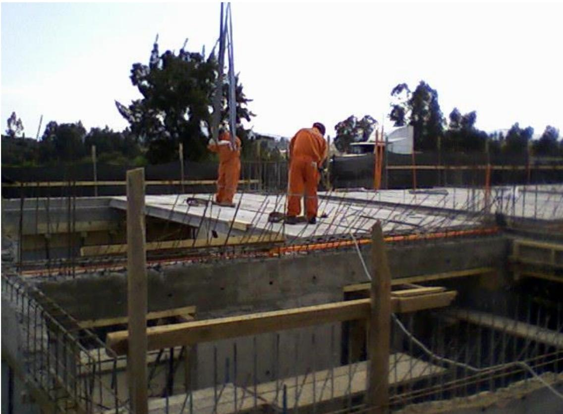
Obra : Centro Comercial Concha y Toro Sistema de elementos prefabricados para centro comercial Sencosud (Easy – Jumbo) Entre piso, viga cercha y costaneras prefabricadas, en módulos de luces de 14 por 24 metros.
