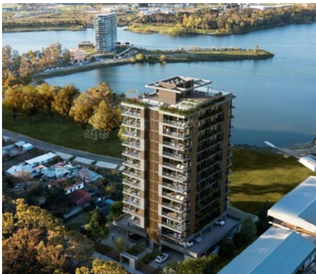
BORNEO LAGO Structural detailed design Area: 6,300 m 2 Ciudad de la Costa · Uruguay
