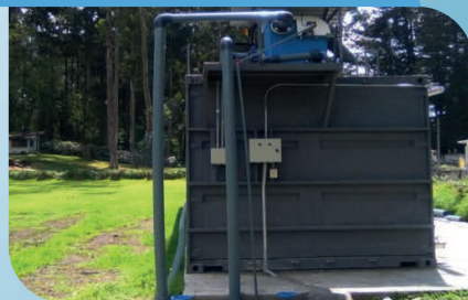
Planta de Tratamiento de Aguas Residuales Domésticas / Biosem / Caudal: 30 m 3 /d / Segmento: Alimentos y Bebidas
