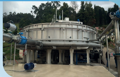
Sistema de Potabilización de Agua / Sistema de Flotación y Filtración DAFFI / Caudal: 12,960 m 3 /d / Segmento: Municipal
