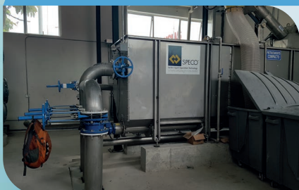
Planta de Tratamiento de Aguas Residuales Domésticas / Lodos Activos tipo SBR / Caudal: 640 m 3 /d / Segmento: Hospitalario
