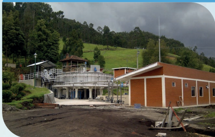
Sistema de Potabilización de Agua / Sistema de Flotación y Filtración DAFFI / Caudal: 12,960 m 3 /d / Segmento: Municipal
