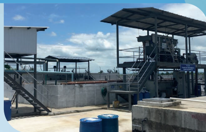
Planta de Tratamiento de Aguas Residuales Industriales / Lodos Activos / Caudal: 180 m 3 /d / Segmento: Camal
