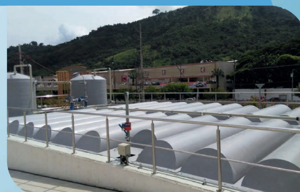
Planta de Tratamiento de Aguas Residuales Domésticas / Lodos Activos tipo SBR / Caudal: 640 m 3 /d / Segmento: Hospitalario
