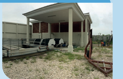
Planta de Tratamiento de Aguas Residuales Domésticas / Biocontactores Rotativos / Caudal: 390 m 3 /d / Segmento: Residencial
