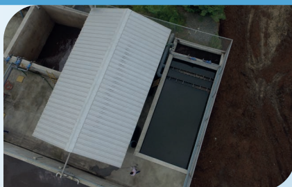
Sistema de Tratamiento de Aguas Residuales Industriales / Lodos Activos / Caudal 1500 m 3 /d / Segmento: Alimentos y Bebidas
