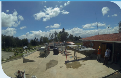
Sistema de Potabilización de Agua / Sistema de Flotación y Filtración DAFFI / Caudal: 12,960 m 3 /d / Segmento: Municipal
