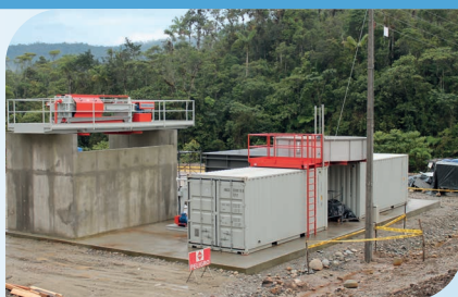
Planta de Tratamiento de Aguas Residuales Industriales / Flotación por Aire Disuelto / Caudal: 1920 m 3 /d / Segmento: Minera
