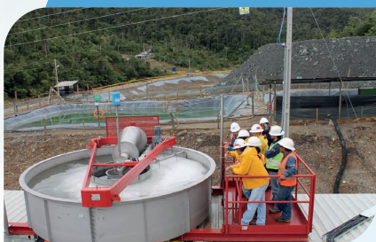
Planta de Tratamiento de Aguas Residuales Industriales / Flotación por Aire Disuelto / Caudal: 1920 m 3 /d / Segmento: Minera
