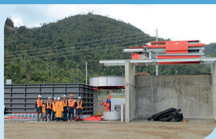
Planta de Tratamiento de Aguas Residuales Industriales / Flotación por Aire Disuelto / Caudal: 1920 m 3 /d / Segmento: Minera
