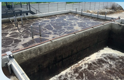
Planta de Tratamiento de Aguas Residuales Industriales / Lodos Activos / Caudal: 180 m 3 /d / Segmento: Camal
