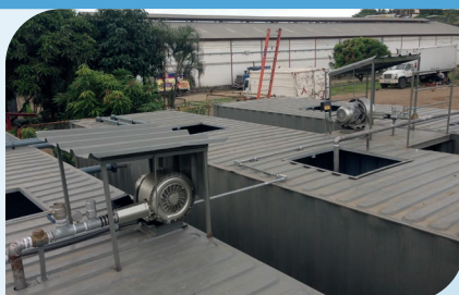
Planta de Tratamiento de Aguas Residuales Industriales / Biosem / Caudal: 100 m 3 /d / Segmento: Alimentos y Bebidas
