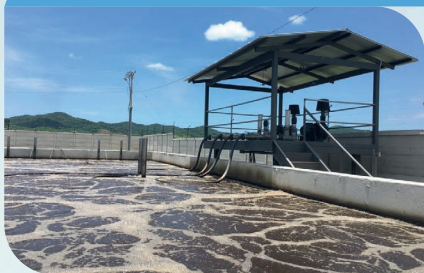
Planta de Tratamiento de Aguas Residuales Industriales / Lodos Activos / Caudal: 180 m 3 /d / Segmento: Camal
