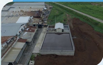
Sistema de Tratamiento de Aguas Residuales Industriales / Lodos Activos / Caudal 1500 m 3 /d / Segmento: Alimentos y Bebidas
