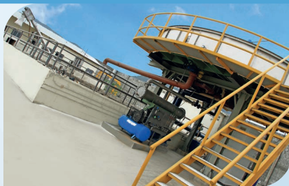
Planta de Tratamiento de Aguas Residuales Domésticas / Flotación por Aire Disuelto / Caudal: 5280 m 3 /d / Segmento: Municipal
