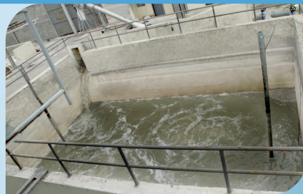
Planta de Tratamiento de Aguas Residuales Domésticas / Flotación por Aire Disuelto / Caudal: 5280 m 3 /d / Segmento: Municipal
