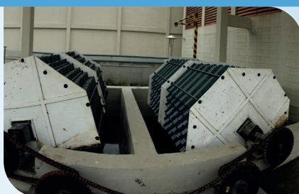
Planta de Tratamiento de Aguas Residuales Domésticas / Biocontactores Rotativos / Caudal: 390 m 3 /d / Segmento: Residencial
