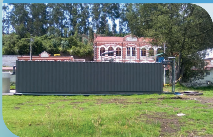
Planta de Tratamiento de Aguas Residuales Domésticas / Biosem / Caudal: 30 m 3 /d / Segmento: Alimentos y Bebidas
