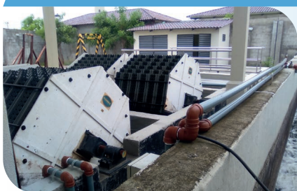
Planta de Tratamiento de Aguas Residuales Domésticas / Biocontactores Rotativos / Caudal: 390 m 3 /d / Segmento: Residencial
