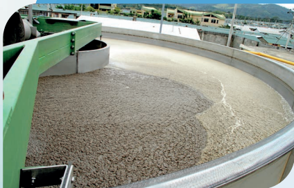
Planta de Tratamiento de Aguas Residuales Domésticas / Flotación por Aire Disuelto / Caudal: 5280 m 3 /d / Segmento: Municipal
