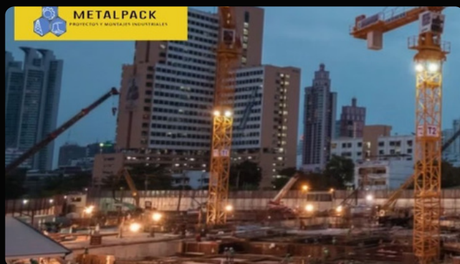
Metalpack Proyectos y Montajes Industriales
