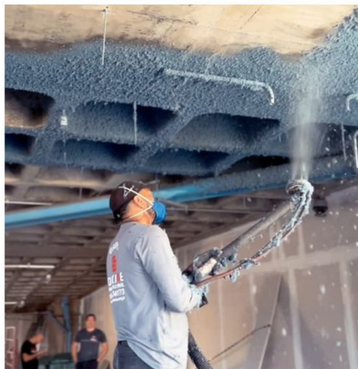
Figura 2 - Foto da aplicação do jateamento Solufibra com composição completa.
