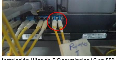
Instalación Hilos de F.O terminales LC en SFP equipo ALU
