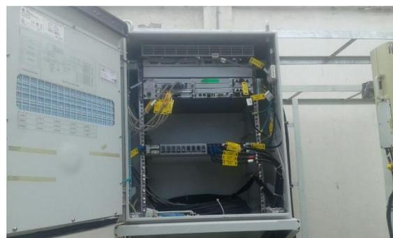
*Instalación de equipos BBU energizado, con su F.O externa, tarjetas funcionando y cableado IP RAN*
