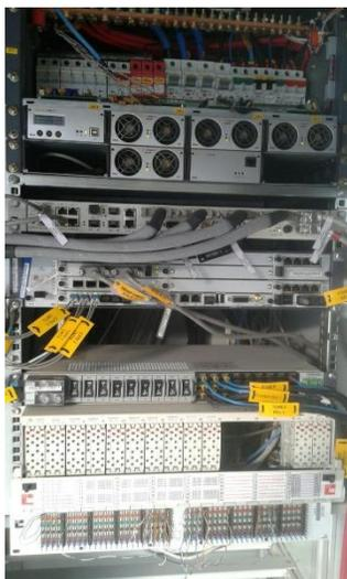
*Instalación de equipos BBU con su F.O externa, tarjetas funcionando y cableado IP RAN*
