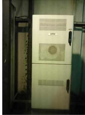
*Vista de APM para Outdoor, aquí se instalan y energizan Equipos para MW y BBUs*
