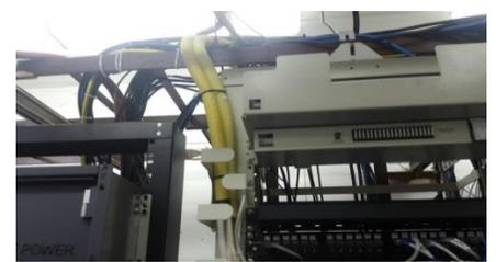
Instalación de manguera corrugada para paso de F.O
