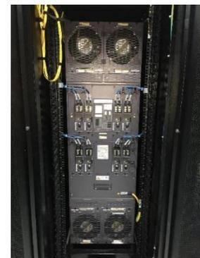
*Cableado de Fuerza Instalado en el Equipo SIG9800*
