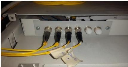
Instalación Hilos de F.O terminales FC en ODF Enlace Pascuales
