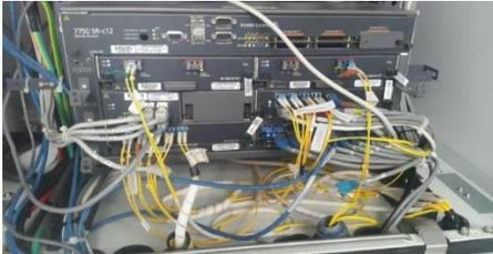
Instalación de Hilos de F.O terminales LC equipo ALU-Pascuales
