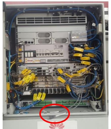
Instalación de UTP Cableado IPRAN en BBU existente
