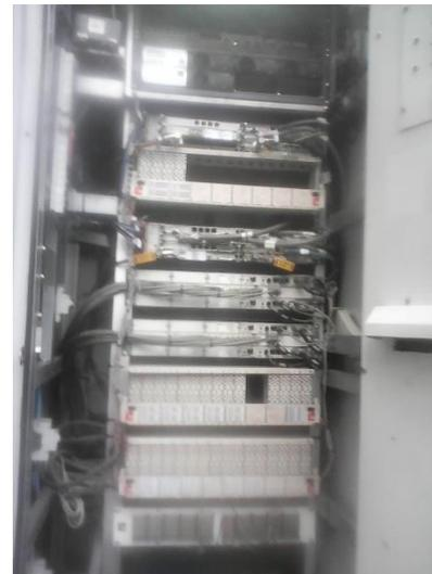
*Instalación de equipos BBU con su F.O externa y tarjetas funcionando*
