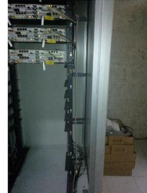
*Instalación de equipos BBU con su F.O externa y tarjetas funcionando*
