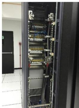
*PDU Habilitada con Cableado de Fuerza para el Equipo*
