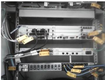
*Instalación de equipos BBU con su F.O externa y tarjetas funcionando*
