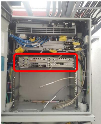
Instalación de Equipo HUAWEI ATN950B en APM RBS villa España, Cableado IPRAN hacia BBU existente
