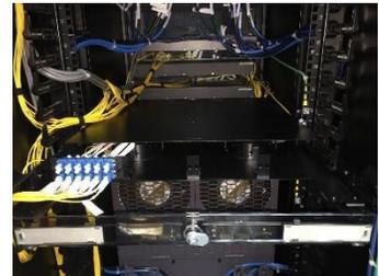
Casetera LC-LC instalada con Cableado TX
