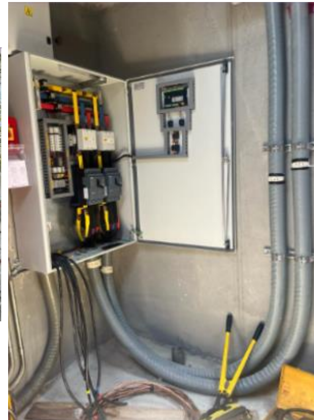
Montaje tableros de transferencia
