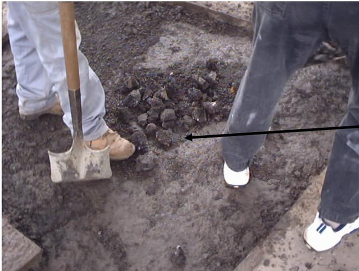
Relleno de huecos con material de asfalto demolido para luego compactarlo llevándolo a 5 cm.
