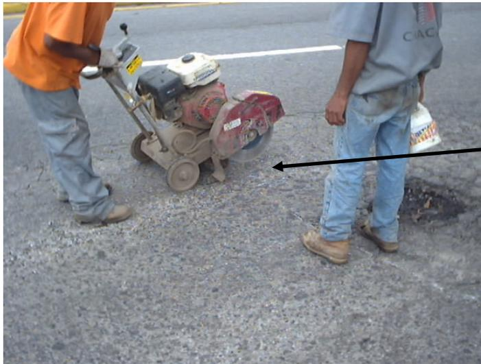
Luego de ubicado el lugar a reparar, se procede a cortar el área utilizando disco de corte o equipo similar.
