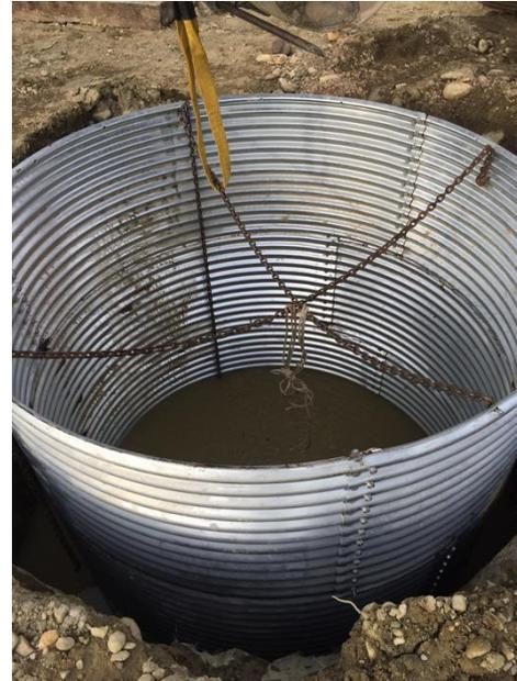
*Imagen Contrapozo posicionado e instalado.*
