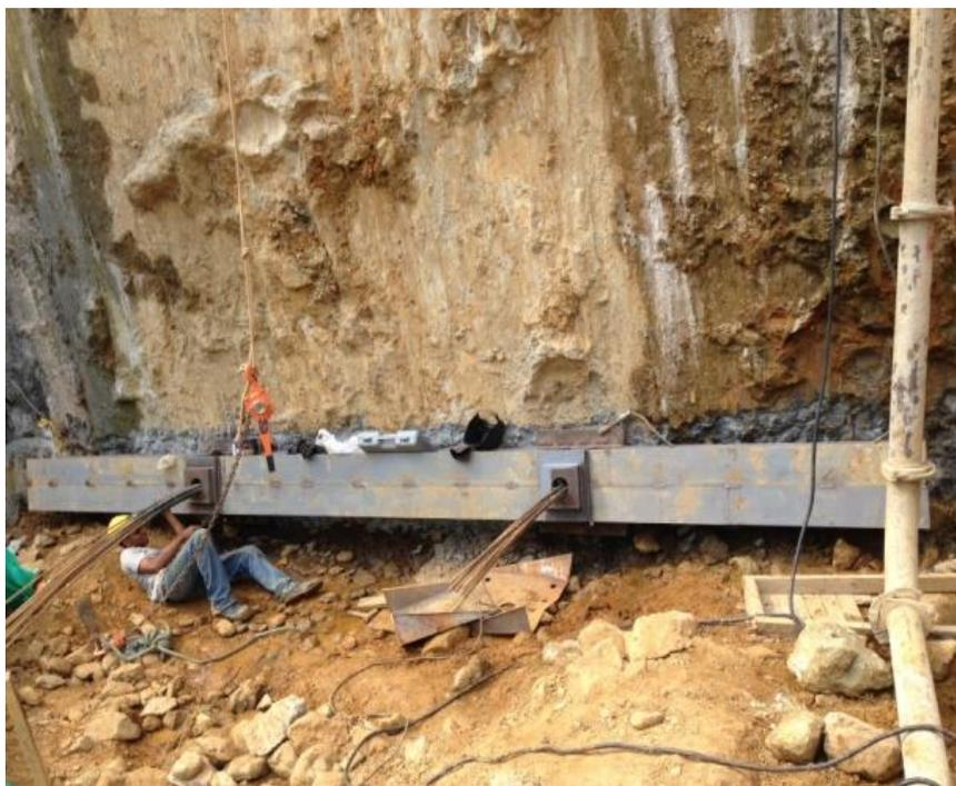
*Vigas metálicas perforadas en el centro para paso de anclajes pasivos TENSION a 110TON, se usaron cartabones de 51mm.*
