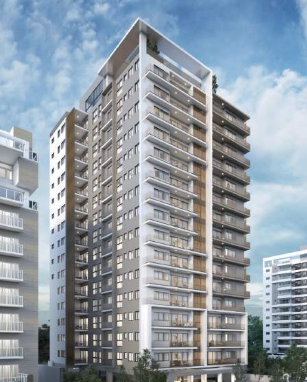
TORRE ELSA SARASOTA EN PROCESO DE CONSTRUCCIÓN
