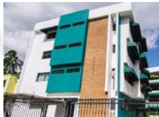
EDIFICIO ELICAROL III
