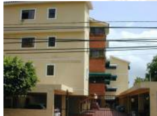
EDIFICIO EDUARDO ERNESTO
