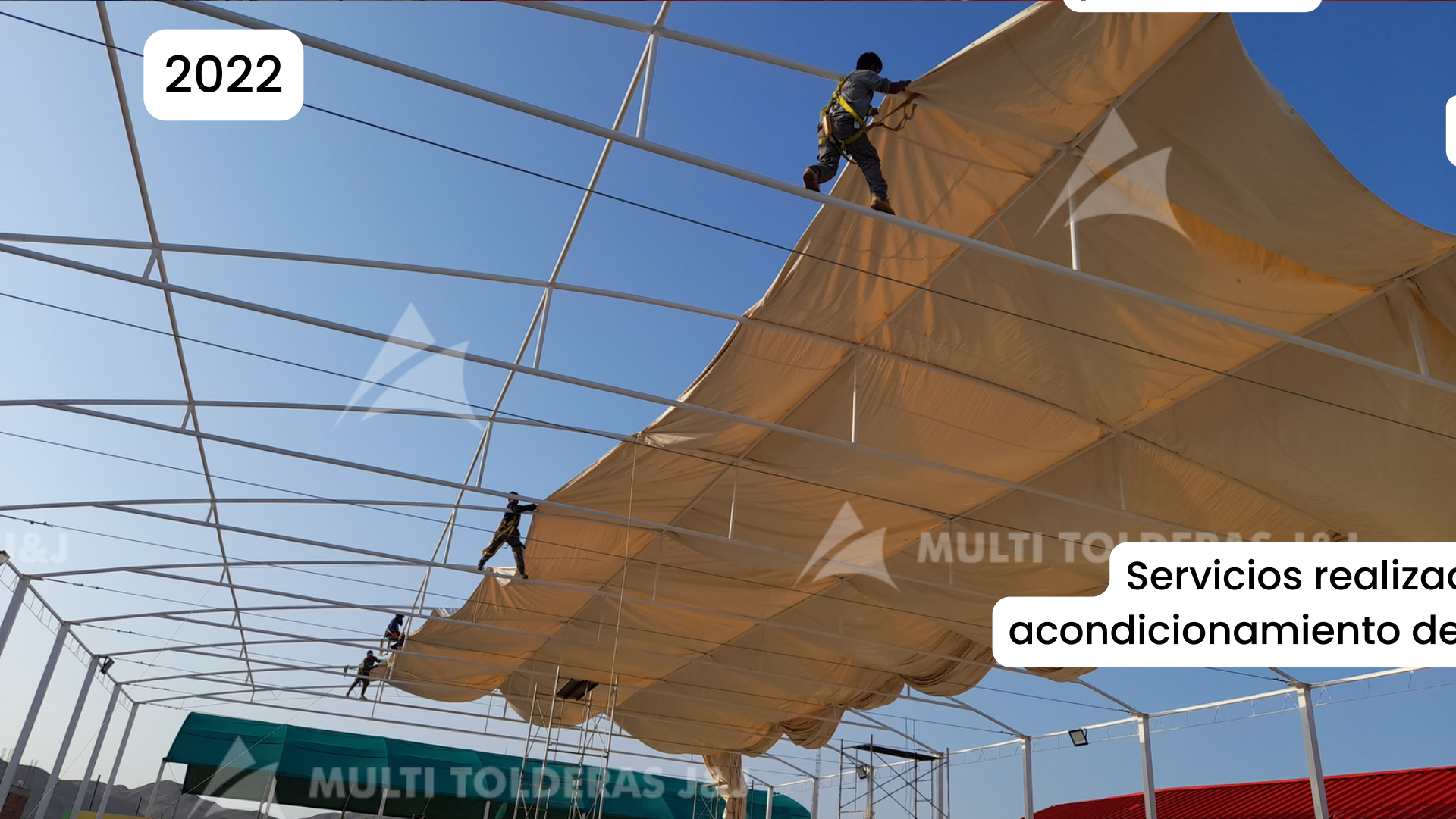
Suministro e instalación de cobertor de lona PVC de 480g/m2 en estructura parabólica.
