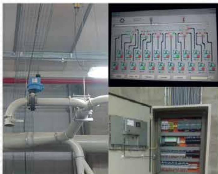
Montaje mecánico, eléctrico, válvulas automáticas y sistema de control para sistema de extracción. Marzo 2017
