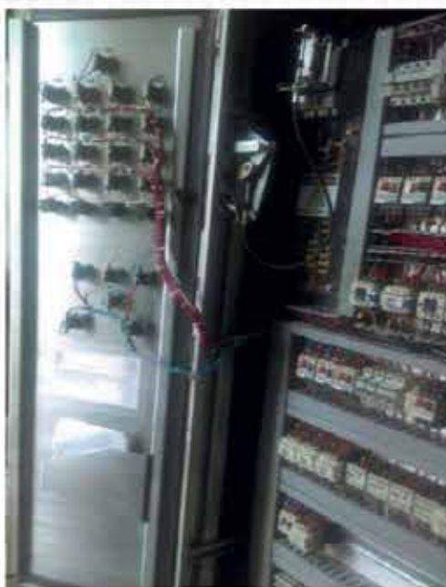
Diseño, fabricación, montaje de tablero inoxidable de operación para la planta de tratamiento de aguas residuales y tuberías conduit. Abril de 2017
