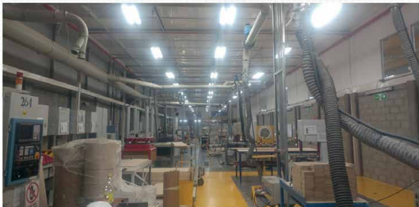
Diseño y construcción de cerramiento para traslado de área de proceso de aislamientos a área de núcleos. Obra civil, mecánica y eléctrica, modificación de sistema de extracción (todos los ductos) y sistema de renovación de aire. Octubre de 2016
