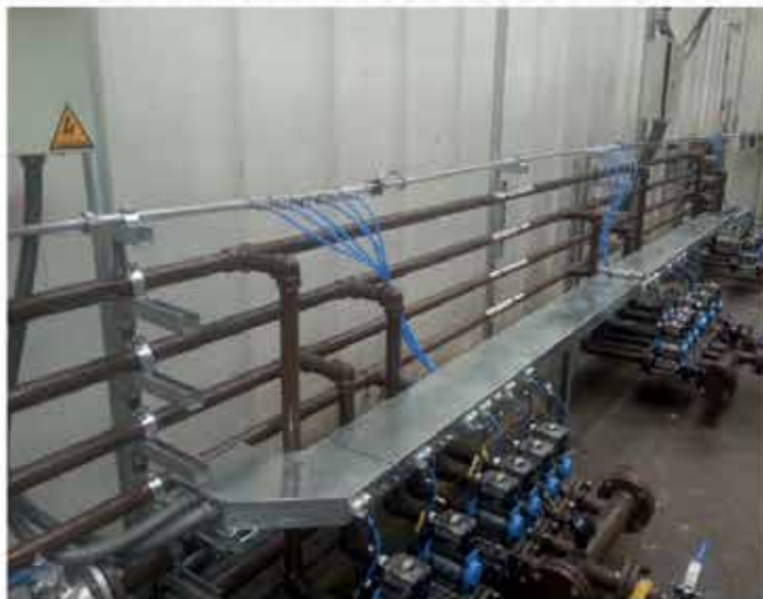
Montajes eléctricos, fabricación de tableros y automatización para nuevo sistema de dosificación de aceite dieléctrico fase III Octubre de 2012
