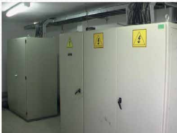
Obras eléctricas, control e instrumentación para la repotenciación del horno eléctrico. Febrero de 2011
