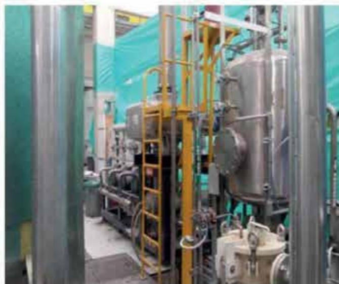
Montajes mecánicos (tubería inoxidable con accesorios), instrumentación y control para horno nicafil. Octubre 2012
