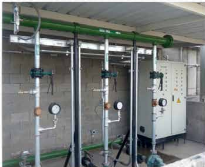
Montajes eléctricos, fabricación de tableros y automatización para nuevo sistema de agua de enfriamiento fase III. Marzo de 2012
