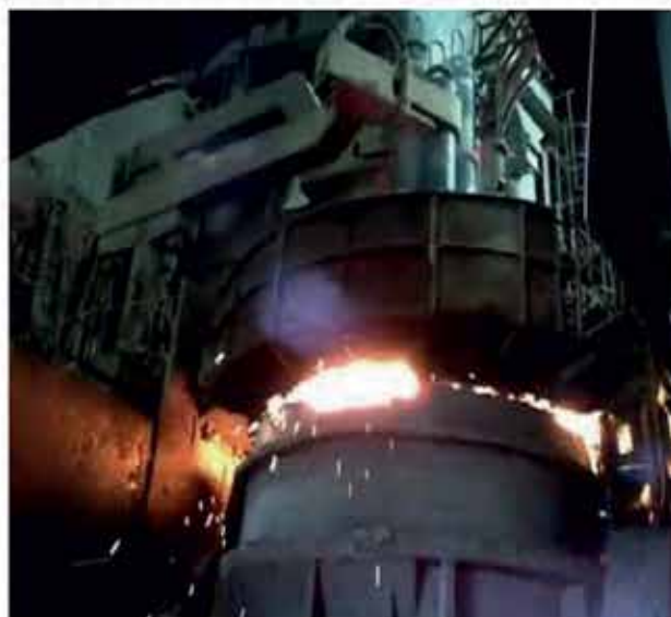
Levantamiento eléctrico y pruebas de arranque del sistema de control del depurador de humos del horno eléctrico. Junio de 2011
