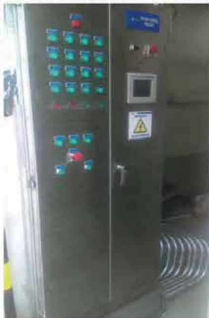
Diseño, fabricación, montaje de tablero inoxidable de operación para la planta de tratamiento de aguas residuales y tuberías conduit. Abril de 2017
