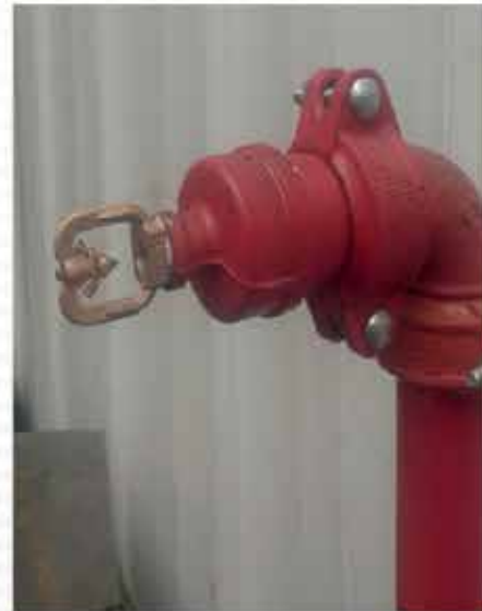
Diseño, suministro, montaje y puesta a punto de sistema de detección y extinción automática utilizado agente NOVEC 1230 para cuartos de generadores y bancos de condensadores. Diciembre 2017
