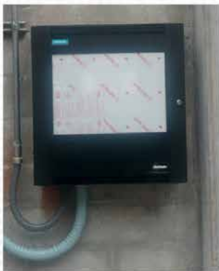
Diseño, suministro, montaje y puesta a punto de sistema de detección y extinción automática utilizado agente NOVEC 1230 para cuartos de generadores y bancos de condensadores. Diciembre 2017
