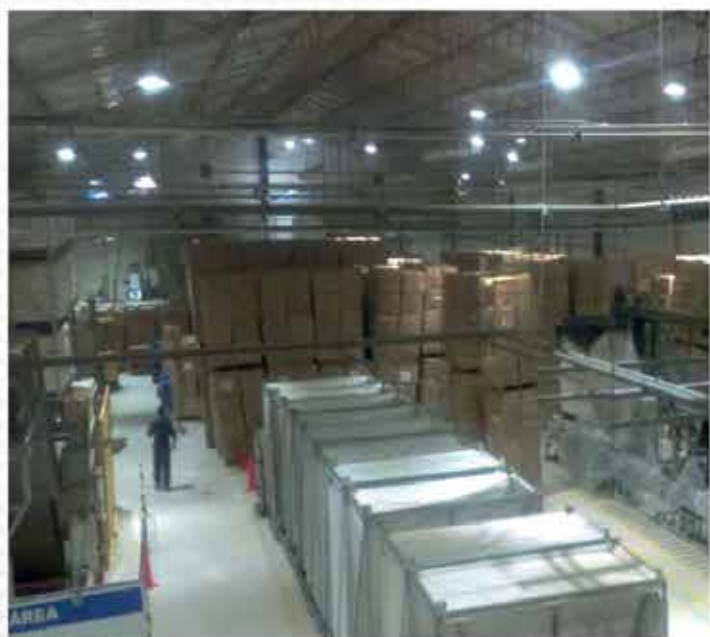
Suministros e instalaciones de iluminación led en nave de blow molding Marzo de 2012
