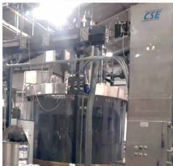
Modificaciones eléctricas y mejora en la programación de máquina tapadora de botellas. Noviembre de 2017
