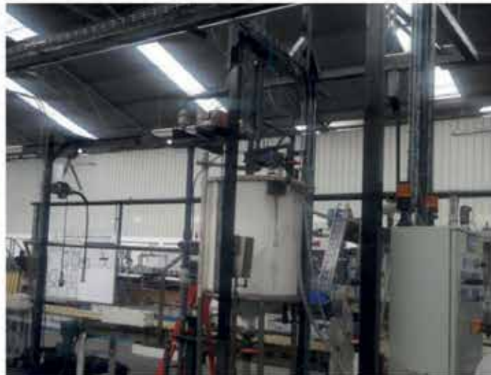
Traslado, eléctrico y control de línea de llenado y embotellado simplex. Diciembre de 2016
