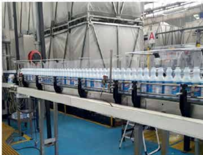
Montajes eléctricos y automatización, para instalación de nueva etiquetadora Krones en la línea de embotellado MSL. Junio de 2016
