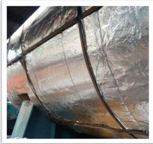
➔ **Aislamiento Térmico secador
