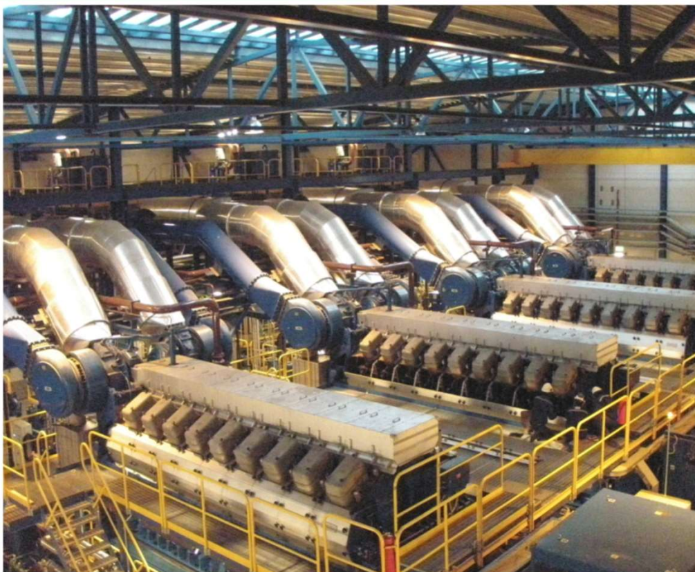
PLUSPETROL-WARTSILA, HUAYURI Bloque 1AB-Planta Generación 40 MVA
