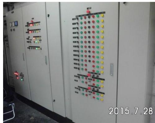
Automatización con PLC de 2 desarenadores
