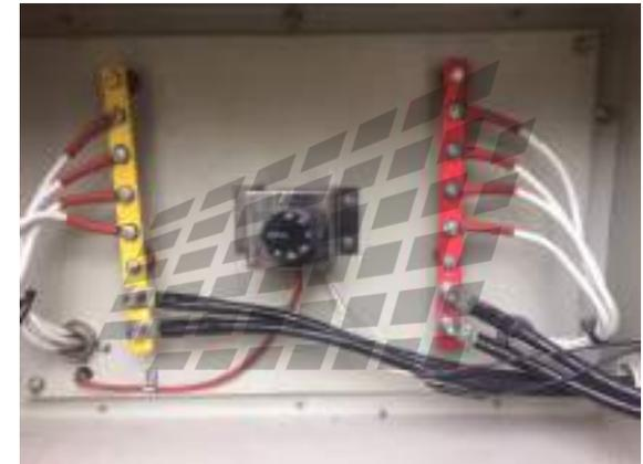
**MODULO DE FRENADO DINAMICO:** Controla la velocidad y el peso en
