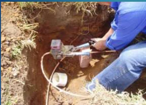
Construcción de sistemas de puesta a tierra según requerimientos específicos siguiendo los criterios de diseño acordes con la normatividad RETIE.
