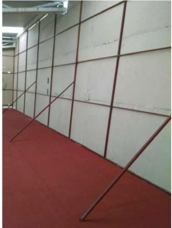
**CONSTRUCCIÓN EN SITIO DE ESTRUCTURA PARA MURO VERDE**
