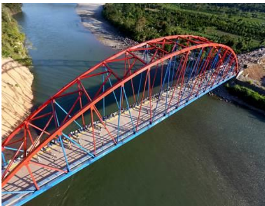
PUENTE PERENÉ - JUNÍN
