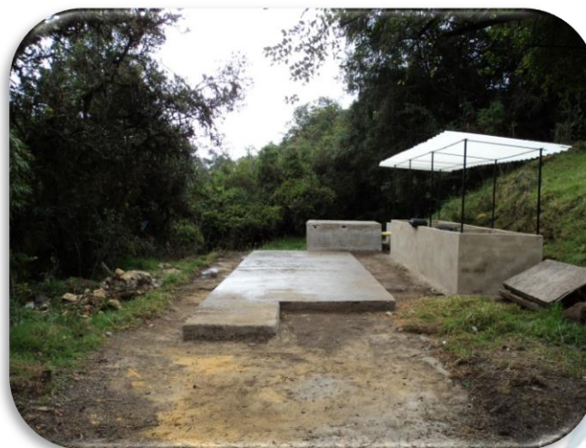
OBRAS CIVILES COMPLEMENTARIAS PTAR COLEGIO LA COLINA
