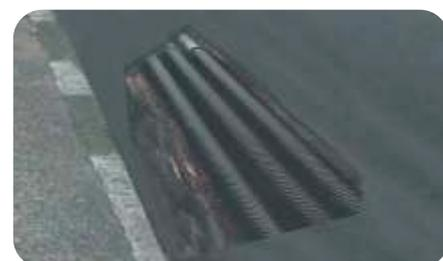
Tubo dreno fabricado em PEAD (polietileno de alta densidade) com secção circular, destinado à coletar e escoar o excesso de líquido filtrado no solo, atende a ABNT NBR 15.073 e pode ser fornecido em rolos ou barras.
