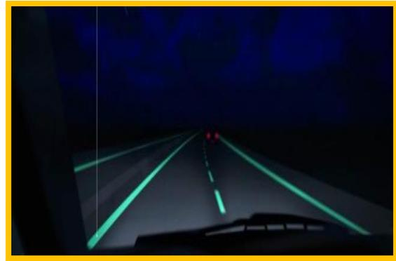
CONCRETO LUMINOSO PARA SEGURIDAD VIAL (Nueva Tecnología Patentada por ORIKA S.A.C.)
