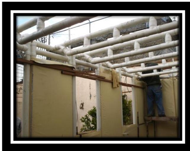
**Muros:** A base de bolsas de lona ya sea cosidas o selladas al calor, rellenas de material producto del terreno natural, oh concreto pobre, oh Mortero, oh una mezcla de terreno natural con cal, Proporción 1:3.
