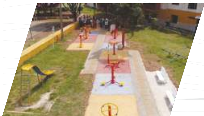
Construcción de escenario deportivo, parque biosaludable Barrio Salomia - Cali.
