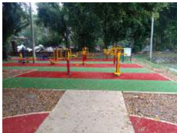
Construcción de escenario deportivo, parque biosaludable Barrio Bolivariano - Cali.
