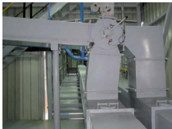
// Instalación de válvula de desvío motorizada en transporte por aerodeslizador
