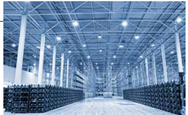
Techos y cubiertas en metal y concreto
