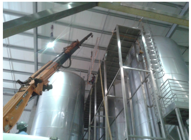
Plataformas e Escadas de Operação.
