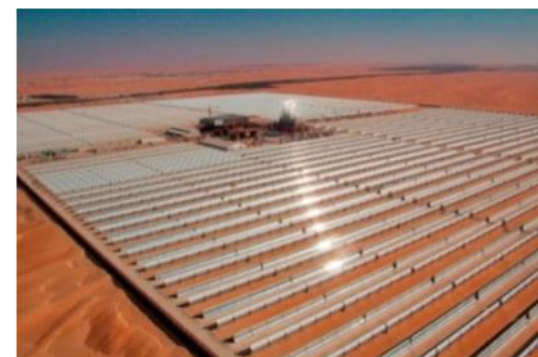
Plantas Fotovoltaicas y Termosolares
