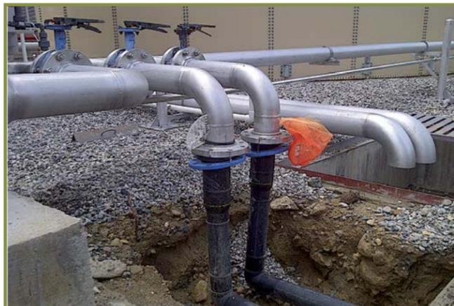
EXTRUCOL, es la tercera empresa en Suramérica en contar con el sello FM Approvals, para tuberías de Polietileno de alta densidad aplicables para redes contra incendio y la primera en contar con clasificación o rating de presión: RDE 11 clase 200 (presión de trabajo: 200 psi).
