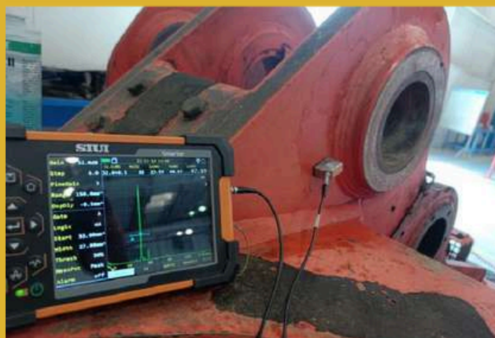
Inspeccion UT angular en estructura de
