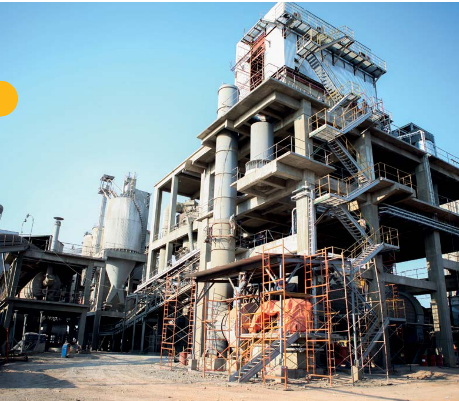
Provisión, Montaje y Puesta en Marcha de Molino de Cemento de 110 TPH – INDUSTRIA NACIONAL DEL CEMENTO Supply, Assembly and Start-up of 110 TPH Cement Mill – INDUSTRIA NACIONAL DEL CEMENTO Provisão, Montagem e Funcionamento de Moimho de Cimento de 110 TPH – INDÚSTRIA NACIONAL DO CIMENTO 國家水泥工業公司 – 110 TPH水泥研磨機的供應、裝配和啟動
