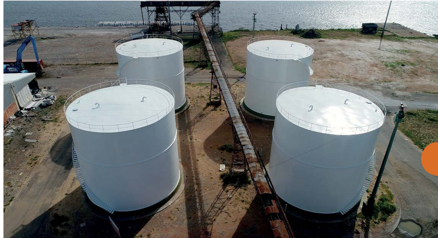
Tanques para Almacenamiento API 650 - PTP GROUP PARAGUAY S. A. API 650 Storage Tanks - PTP GROUP S. A. Tanques para Armazenamento API 650 - PTP GROUP PARAGUAI S. A. PTP GROUP Paraguay S. A.公司 - API 650 儲存罐
