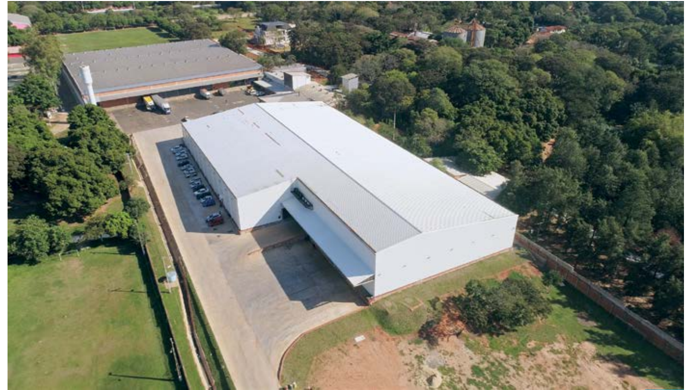
Galpón Industrial de Producción - ALAS S.A. Industrial Production Shed - ALAS S.A. Galpão industrial de Produção - ALAS S.A. ALAS S.A.公司 - 工業生產廠房
