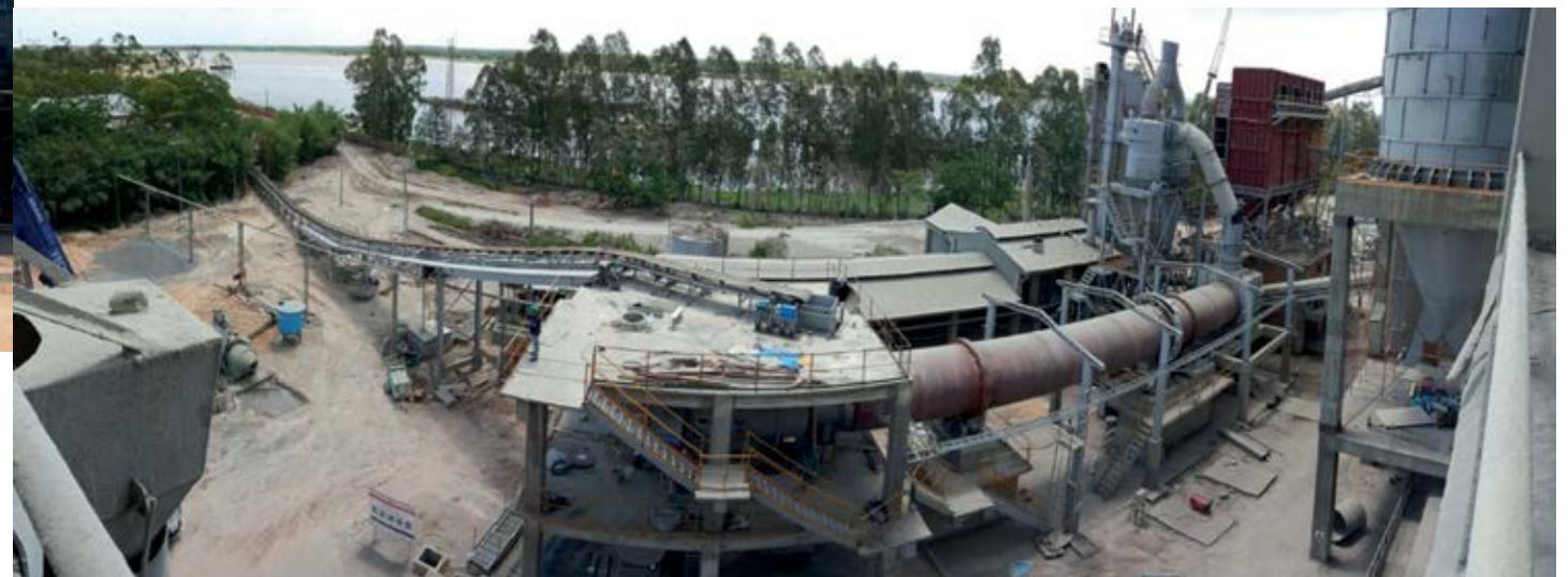
Provisión, montaje y puesta en marcha de Secador de Pozolana de 50 TPH – INDUSTRIA NACIONAL DEL CEMENTO Provision, Assembly and Start-up of 50 TPH Pozzolana Dryer – INDUSTRIA NACIONAL DEL CEMENTO Provisão, montagem e funcionamento de Secador de Pozolana de 50 TPH – INDÚSTRIA NACIONAL DO CIMENTO 國家水泥生產公司 – 50 TPH火山灰乾燥器的供應、裝配和啟動
