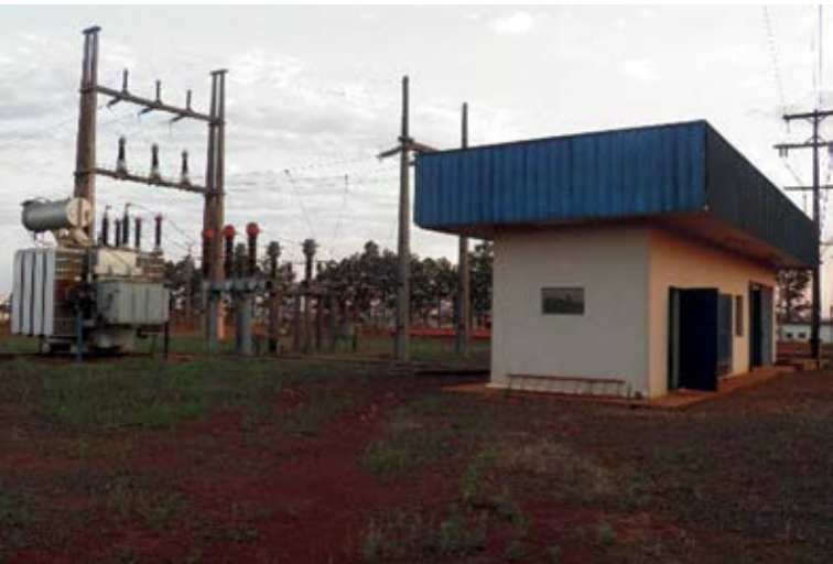
Construcción de la Subestación 66/23 kV - INDUSTRIA PARAGUAYA DE ALCOHOLES S. A. Construction of the 66/23 kV Substation - INDUSTRIA PARAGUAYA DE ALCOHOLES S. A. Construção da Subestação 66/23 kV - INDÚSTRIA PARAGUAIÁ DE ÁLCOOIS S. A. 巴拉圭酒精工業公司 - 66/23 kV變電廠的建設
