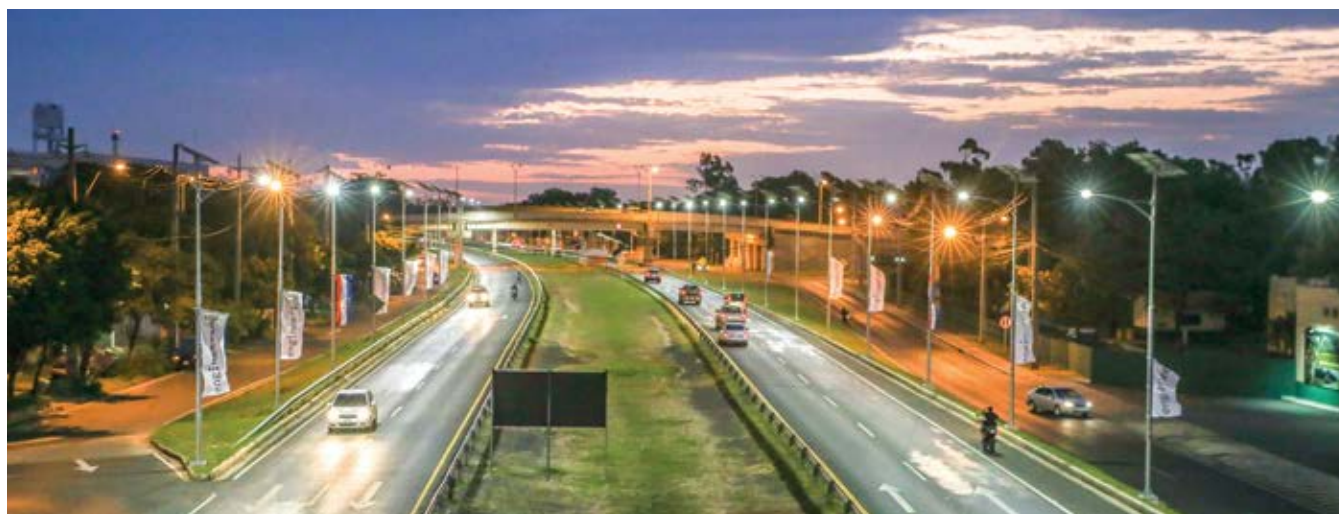
Sistema de Iluminación LED Solar Autopista Ñu Guazú - MINISTERIO DE OBRAS PÚBLICAS Y COMUNICACIONES Ñu Guazú Highway Solar LED Lighting System - MINISTRY OF PUBLIC WORKS AND COMMUNICATIONS Sistema de Iluminação LED Solar Autopista Ñu Guazú - MINISTÉRIO DE OBRAS PÚBLICAS E COMUNICAÇÕES 公共工程及通訊部 - Ñu Guazú高速公路的LED太陽能照明系統
