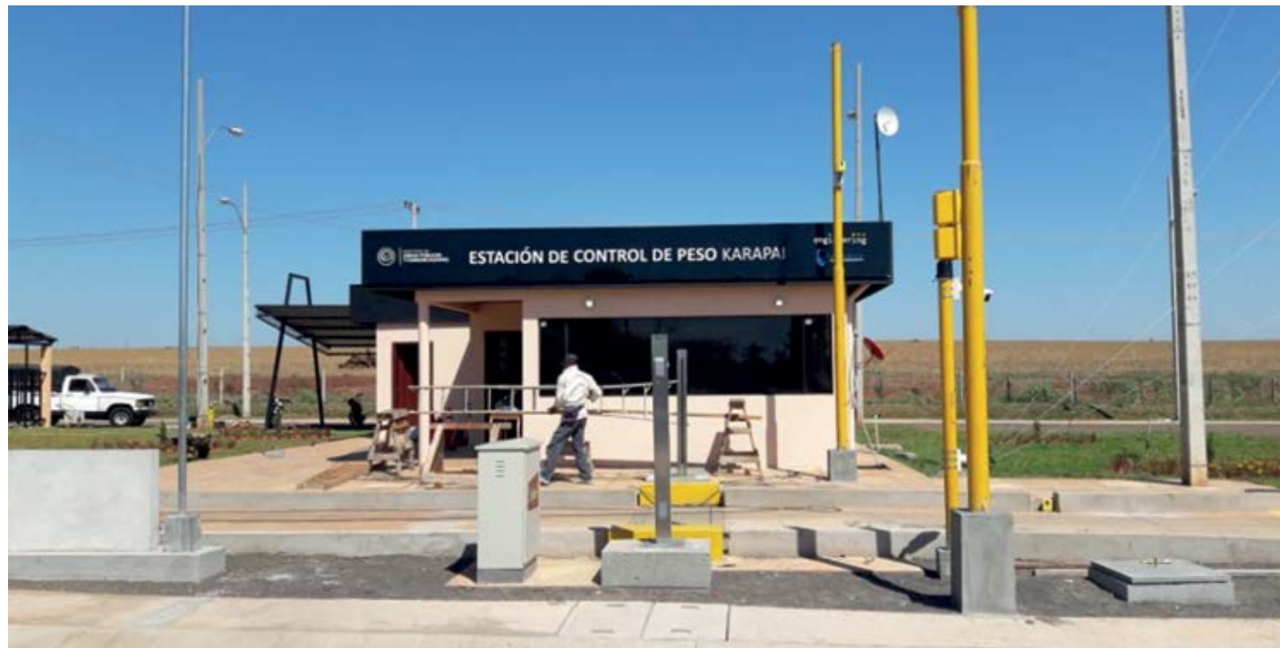
Construcción de Báscula de Pesaje Tramo Santa Rosa Cap. Bado - MINISTERIO DE OBRAS PÚBLICAS Y COMUNICACIONES Construction of Weighing Scale - Santa Rosa-Cap. Bado Section - MINISTRY OF PUBLIC WORKS AND COMMUNICATIONS Construção de Báscula de Pesagem Tramo Santa Rosa Cap. Bado - MINISTÉRIO DE OBRAS PÚBLICAS E COMUNICAÇÕES 公共工程及通訊部 - SANTA ROSA 及CAP. BADO兩個地區之間道路的秤重地磅的建設
