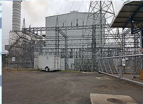
Mantenimiento Subestación Eléctrica
