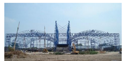
Hangares 2, 3, 4, 5, 6 y 7 Aeropuerto El Salvador
