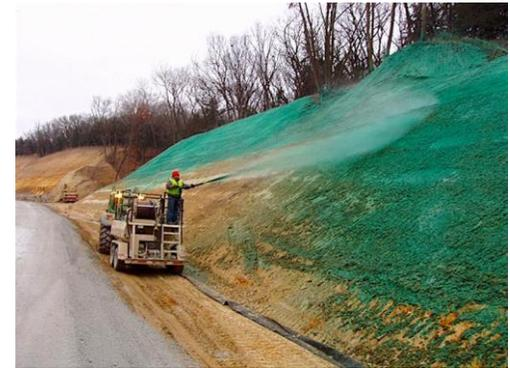
ECOVIAZ®-CP controla a erosão, protegendo e estabilizando encostas e taludes.
