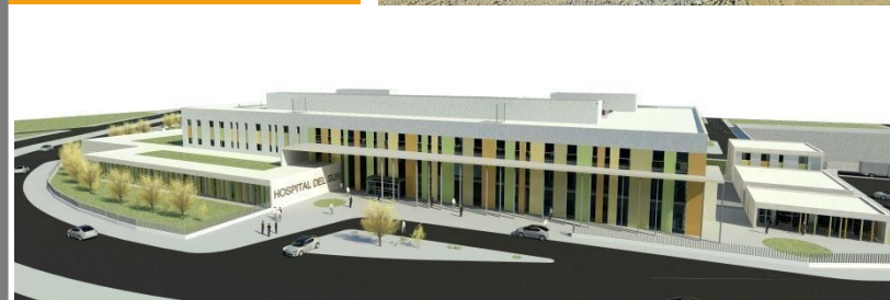
HOSPITAL DEL SUR
