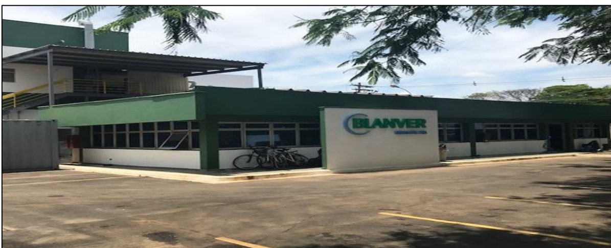
Obra finalizada – 1ª fase – Dezembro/2017
