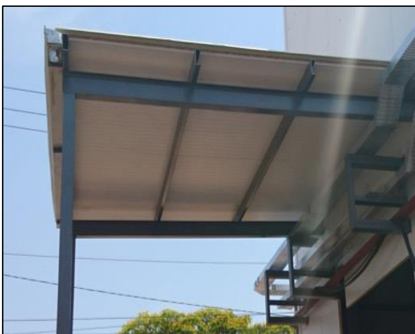
Coberturas metálicas com telhado em aço galvanizado: 72,21m 2
