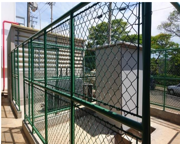
Acréscimo da Subestação: 22m 2
