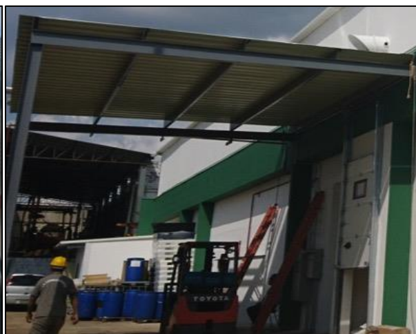
Coberturas metálicas com telhado em aço galvanizado: 72,21m 2
