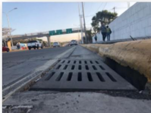
Rejillas Alcantarillas y Peatonal
