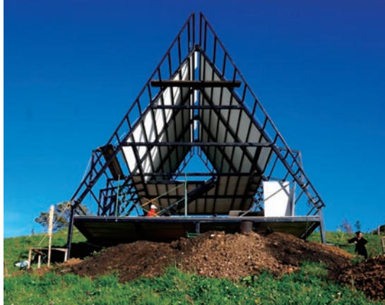
Proyecto: Casa en Sistema Corpacasa Ciudad: La Calera Producto: Estructura Metálica y Corpalosa
