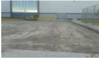
Conformación de subbase para colocación de piso de concreto armado en planta ABINSA ubicada en el parque industrial Querétaro.
