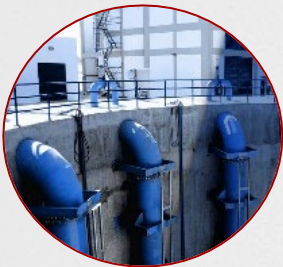
Obras infraestructura Hidráulica
