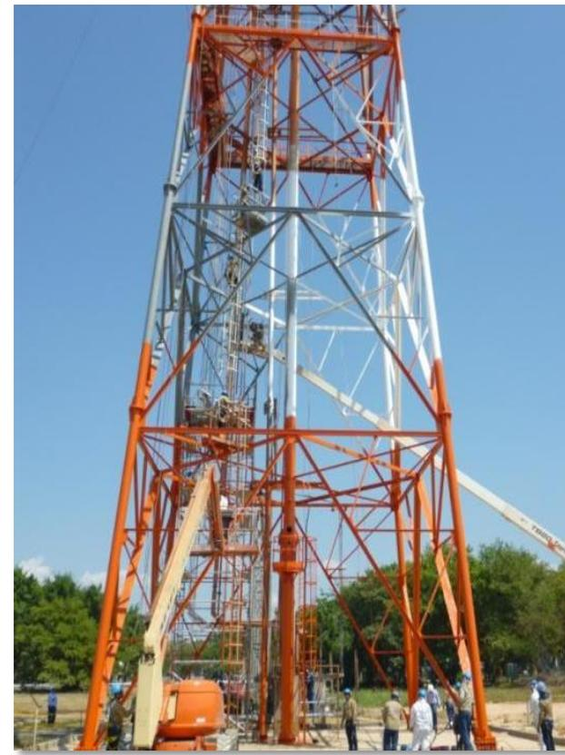
**Imagen 11.** Mantenimiento de pintura en la torre de la flare stack y tuberías de proceso – Ecopetrol.
