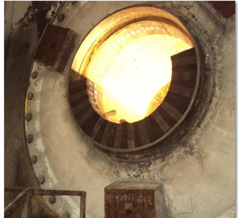
Imagen 8. Aplicación de Refractario en calderas y hornos.
