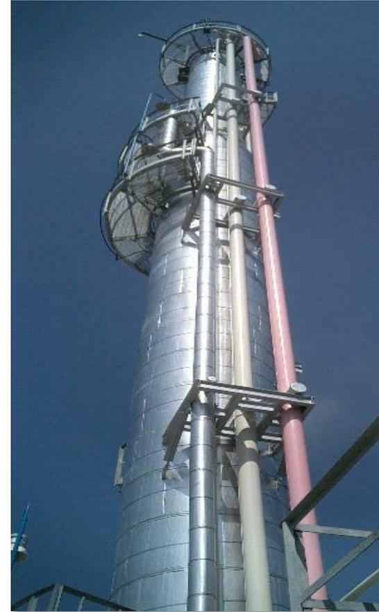
**Imagen 7.** Trabajos Aislamiento térmicos de equipos.
