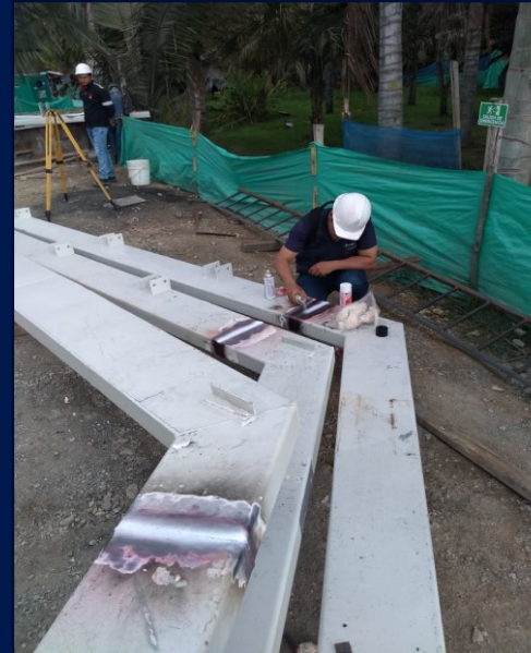
Prueba de tintas penetrantes a la soldadura
