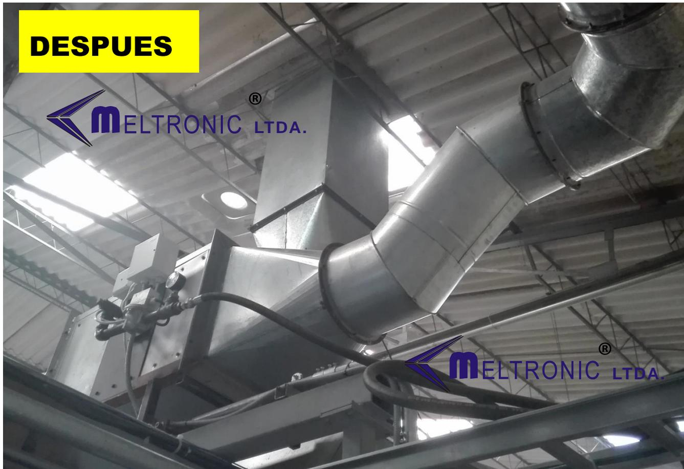
QUEMADOR VENA DE AIRE - EQUIPO DE SECADO TEXTIL
