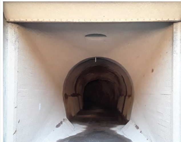
Túnel de conducción proyecto hidroeléctrico Chamelecón Honduras
