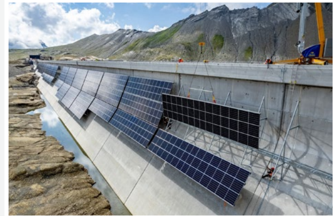
Presa y planta solar de Mutsee Suiza
