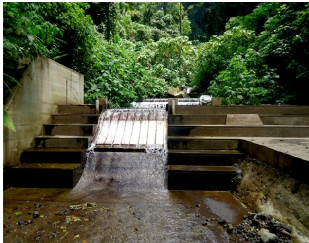
Proyecto hidroeléctrico Coralito Guatemala
