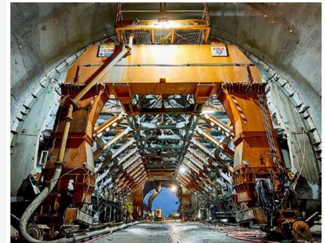
Saneamiento túnel de conducción proyecto hidroeléctrico Changuinola Panamá
