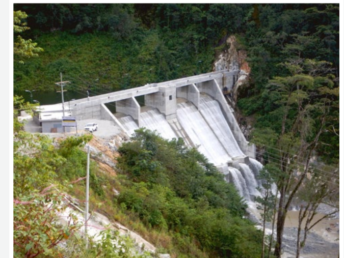
Proyecto hidroeléctrico Ojo de Agua Honduras
