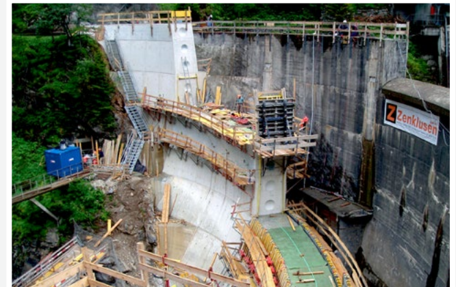
Presa de Serra Suiza
