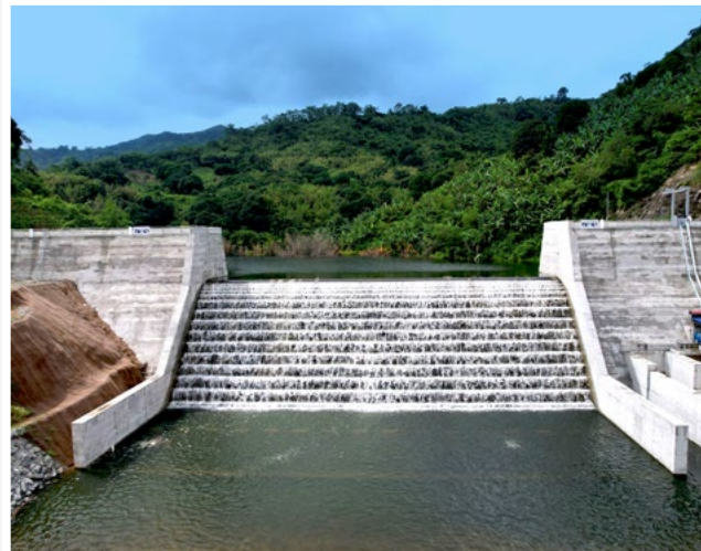
Sistema de agua potable Wawa Filipinas
