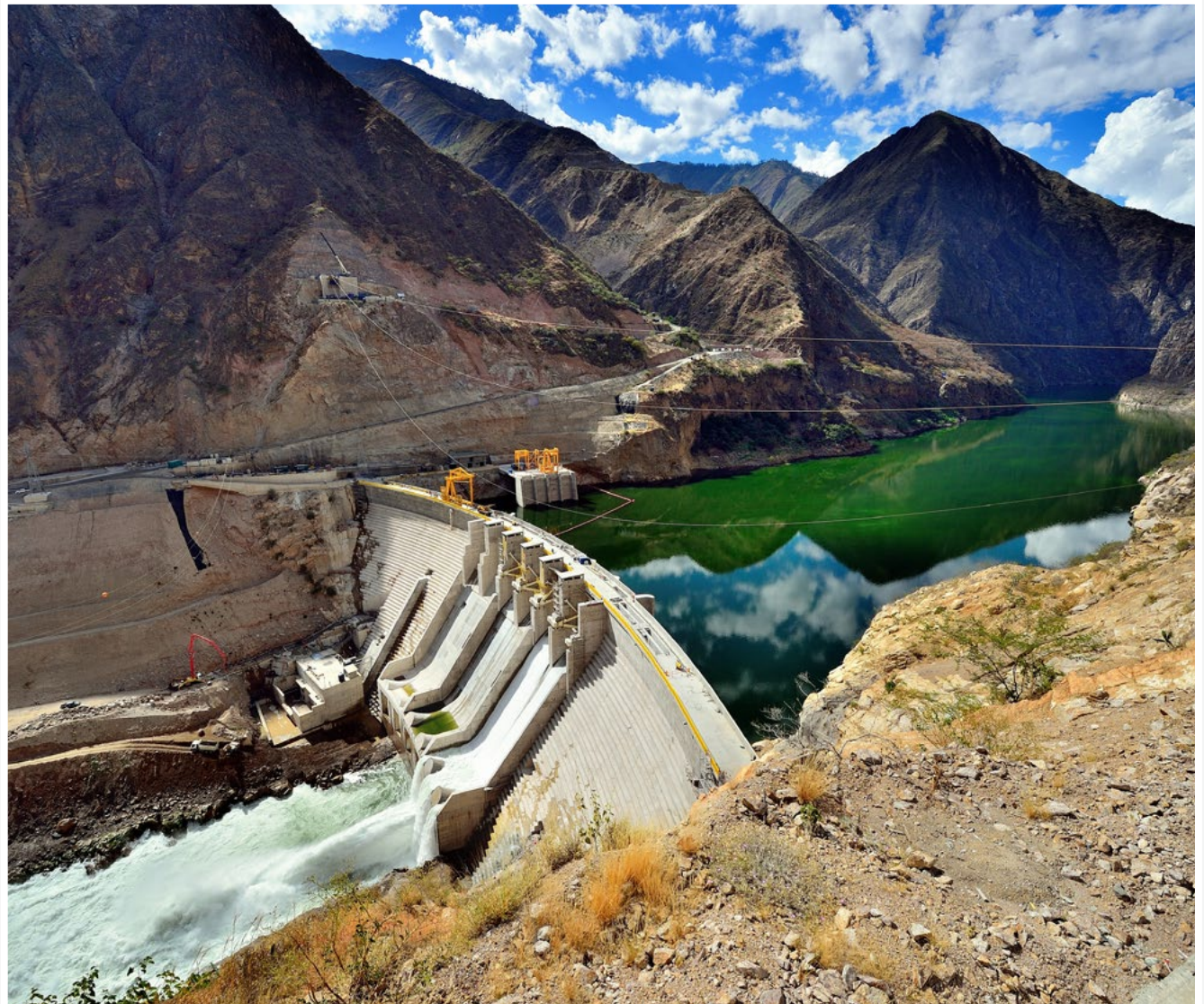
Proyecto hidroeléctrico Cerro del Águila Perú
