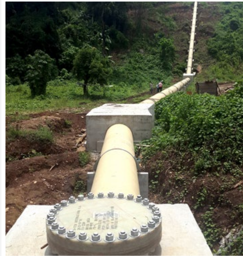
Proyecto hidroeléctrico Las Uvitas Guatemala
