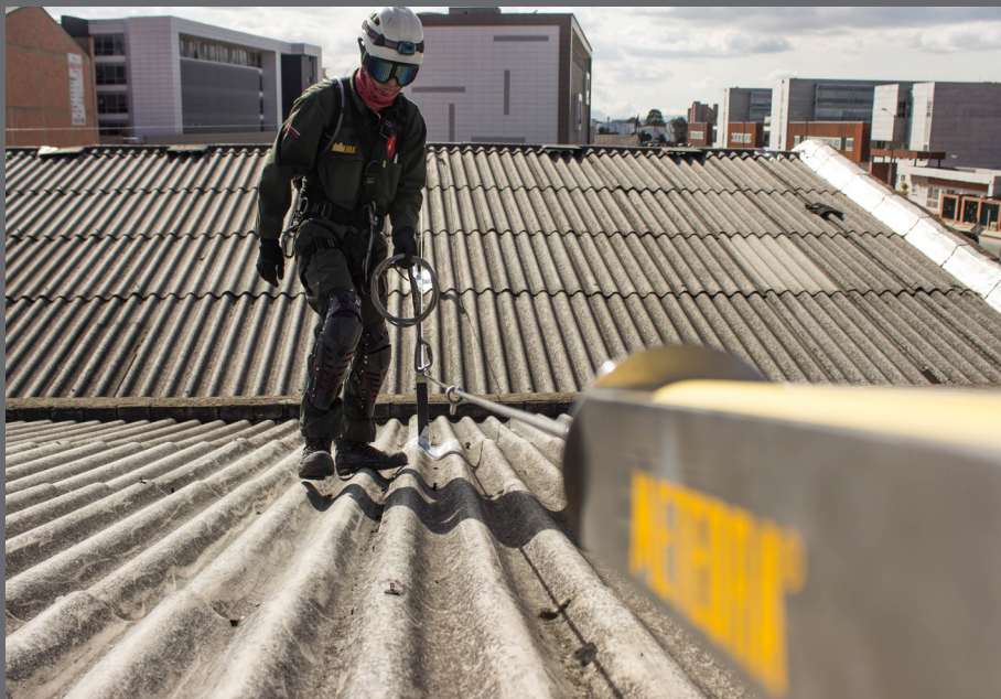
Las líneas de vida METEORA son adaptables a diferentes factores de caída.
