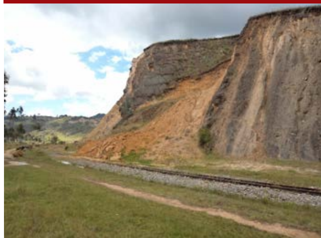
Inestabilidad por falla rotacional en talud interno
