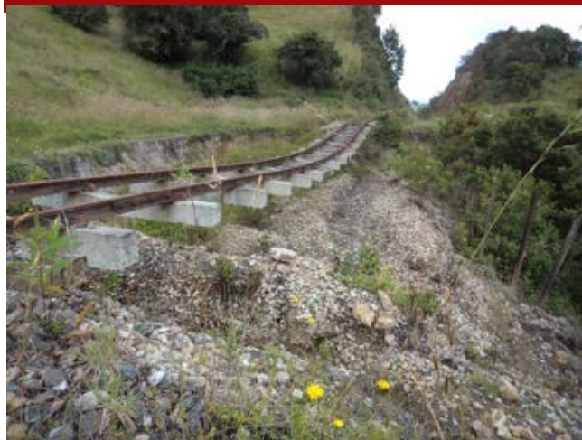
Inestabilidad por falla rotacional en talud externo
