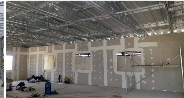
INSTALACIÓN DE DRYWALL
