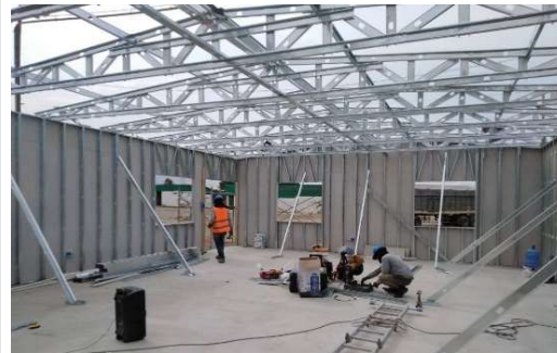
INSTALACIÓN DE DRYWALL
