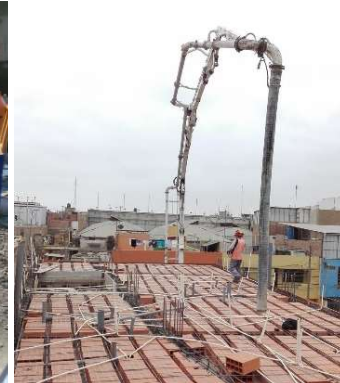
VACIADO DE TECHO
