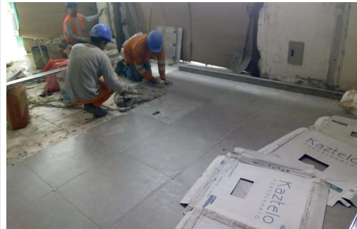
COLOCACIÓN DE ENCHAPE
