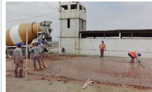
VACIADO DE LOSA
